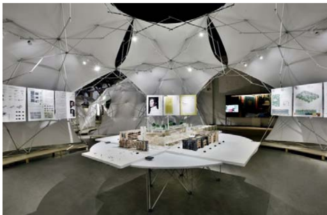
圖 1. 穹頂結構由鋁管組構，具組合彈性且可回收再利用，03 區「他，翻轉偏見」由邱文傑邀請四組年輕建築師以民生社區街廓的都市更新。(資料來源：汪德範 Te-Fan Wang 攝影，格式設計展策 InFormat Design Curating 提供。)
