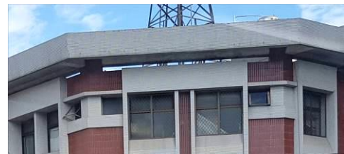
圖 43. 女兒牆 / 裝飾物外推，與牆面間留縫的 案例：臺中市民權派出所 (資料來源：筆者攝)
