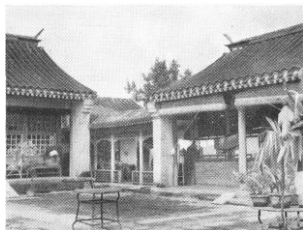
圖 22. 北京四合院住宅 1953 年照片、測繪平面圖及分析圖。量體、牆體標示黑色，半戶外空間、迴廊標示灰色。從中可見留設露地／漏角天井、貫通的遊廊等特徵。 （左圖、中圖資料來源：劉敦楨，1957，頁 103、101；右圖資料來源：筆者繪）
