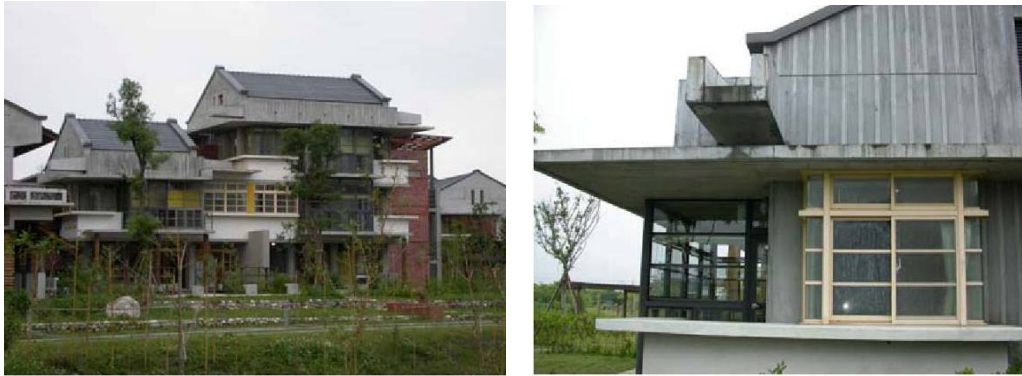
圖 11：將風土民居的防颱簷板轉化為排水的天溝—傳藝宿舍
