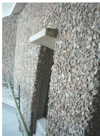
圖 6：以興建北宜高所開挖出的四稜砂岩做表面材料—礁溪戶政事務所
