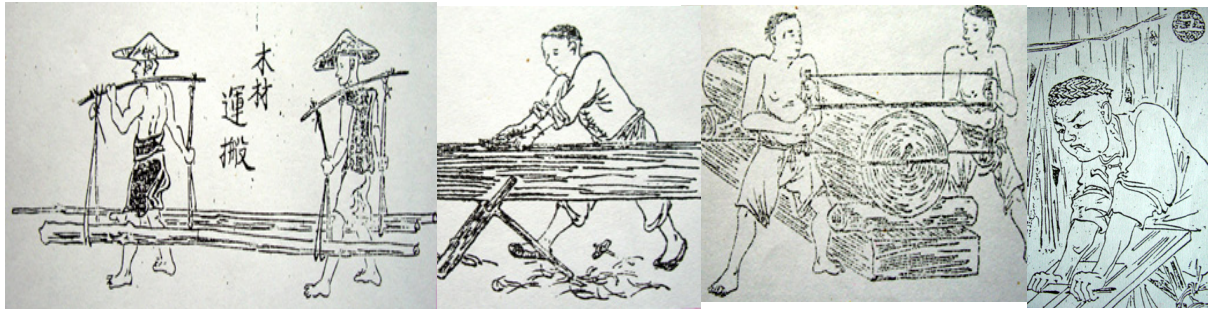
圖16 日人眼中的台灣製材與木工相關技術操作的實景插圖
