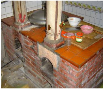
圖 15：施詠勝師傅製作之灶，每一灶眼配一煙囪，灶口上方嵌有陶瓷飾板
