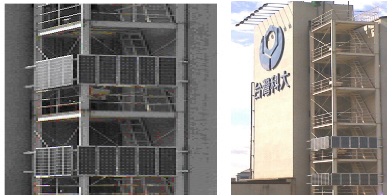
圖 7 光電板外掛於外牆構造之實作模型
