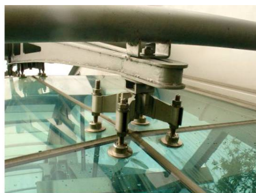
圖 26. 半球溫室：(a) 屋頂面細部 3D 示意圖 5 (b) 屋頂面細部照片
