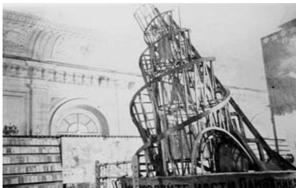
圖 7：V. Tatlin, Monument to the Third International, 1920[33, p.133]。包括一個傾斜的螺旋鐵架、支撐玻璃圓筒、玻璃錐體和玻璃立方體，上述元素以不同的速度轉動。
